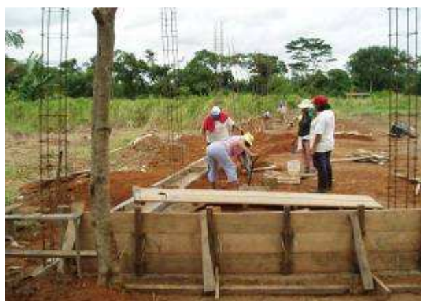
Début de la construction du mur de clôture
