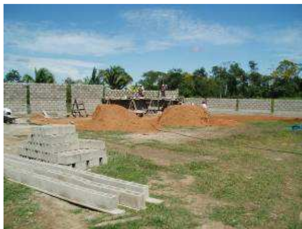
Le mur de clôture en bonne voie d'achèvement
