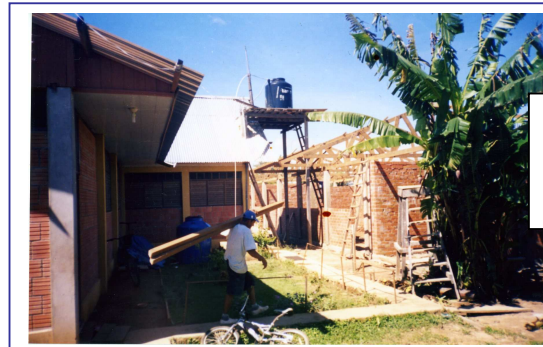
Dortoir en travaux à coté de la cuisine
