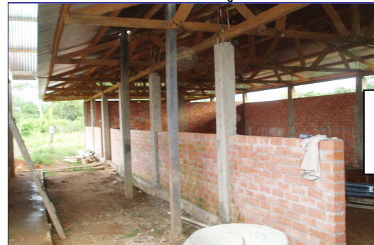
Dortoir en cours de réalisation
